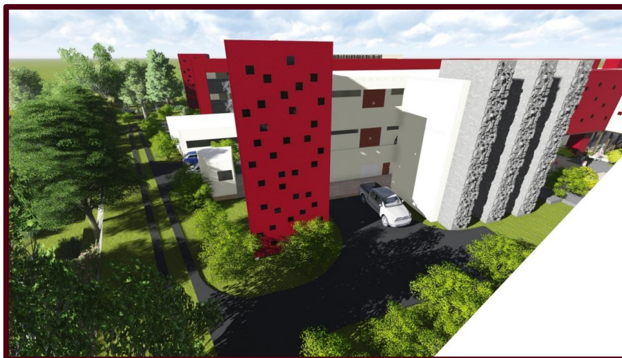
Vista No. 34: Área de Servicio. Fuente: Elaboración propia, 2016
