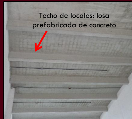
Fotografía No. 49: Techo de Locales Fuente: Elaboración Propia, 2016.
