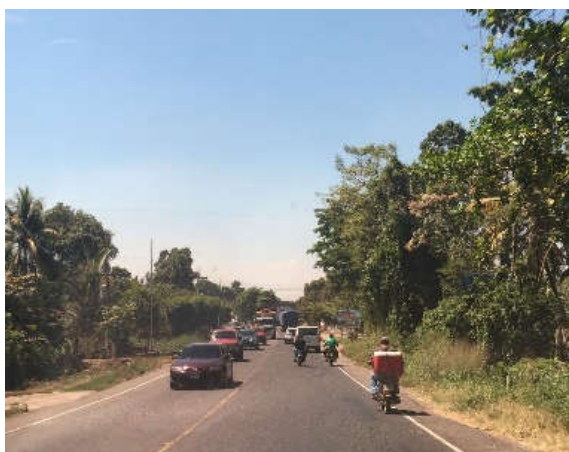
Vista de vía CA-2 / 1ra Avenida
