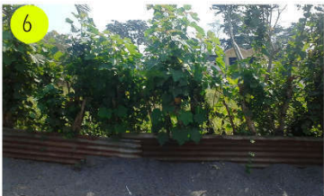
Vista exterior lateral hacia polígono
