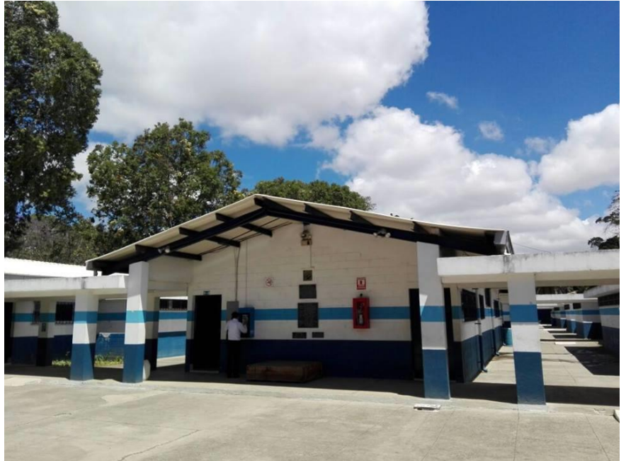
Ilustración 18 Modulo de habitaciones Fuente: Propia
