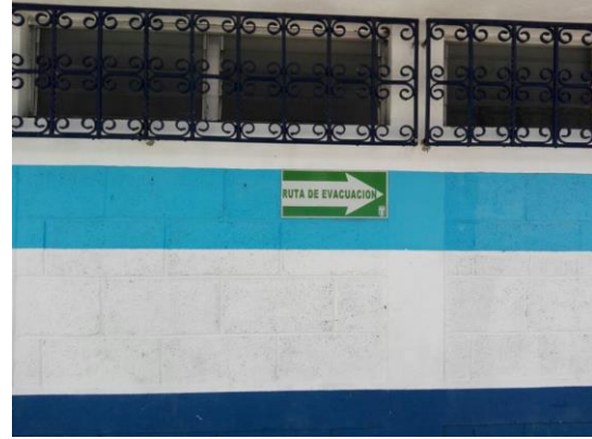
Ilustración 24 Pasillos de módulos para habitaciones
