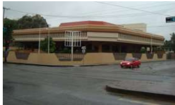
Foto No. 53: Perspectiva desde boulevard Agustín de Vildósola, Casa de la Cultura de Sonora. Fotografía: Anónimo
