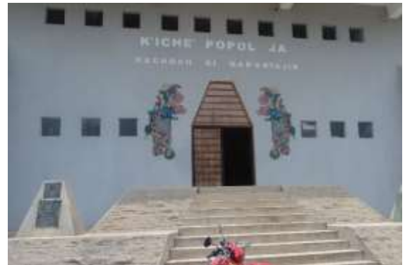
Foto No. 40: Vano de puertas y ventanas. Fuente: visita de campo 2016
