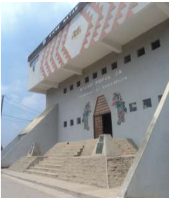
Foto No. 48: Vista ingreso a centro cultural K'iche' Fuente: visita de campo 2016
