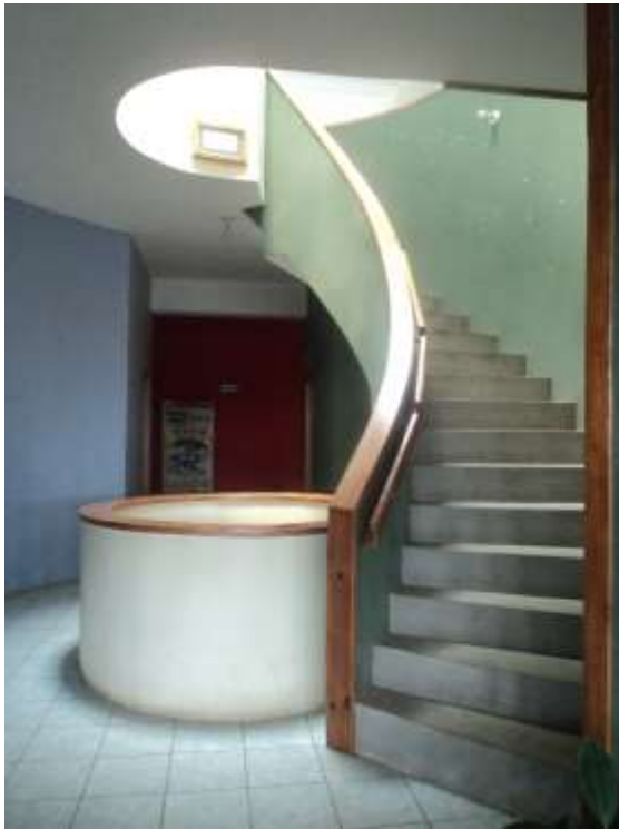
Foto No. 43: Gradas tipo helicoidal. Comunica la planta dos y tres. Fuente: visita de campo 2016
