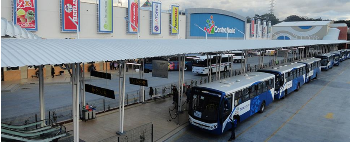
Foto No. 26 Fachada principal Fuente: http://www.conconcreto.com
