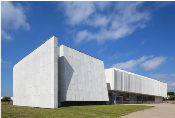
Ilustración 1 Fachada frontal Escuela de Arte - Carcassonne /Jacques Ripault FUENTE: 6 noviembre 2015 www.archdaily.com/600686/art-school-carcassonne-jacques-ripault-architecture .
