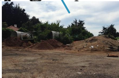
Ilustración 35 Terreno baldío en la actualidad FUENTE: 7 de noviembre 2015 Elaboración propia
