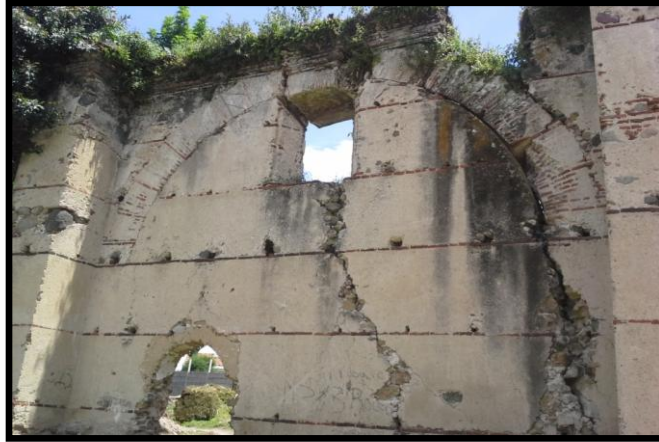
FOTOGRAFÍA 6, Elaboración propia, visita de campo. (año 2014). Vista de muro lateral.
