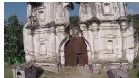
Fuente fotográfica: www.munivillacanales.com/villacanalesenimagenes.html# Pagina oficial Municipalidad de Villa Canales
