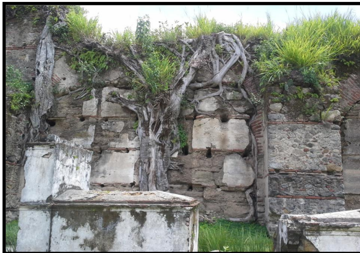
FOTOGRAFÍA 7, Elaboración propia, visita de campo. (año 2014). Vista de muro lateral.
