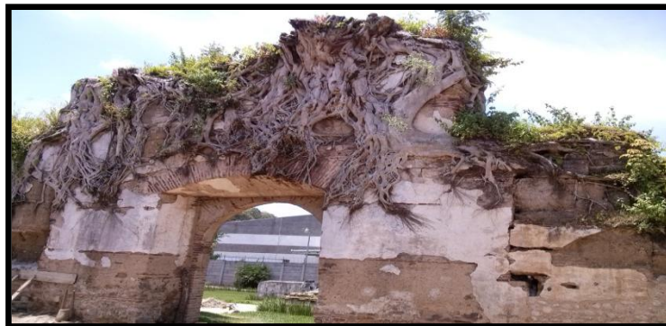
FOTOGRAFÍA 9, Elaboración propia, visita de campo. (año 2014) Vista muro interior.
