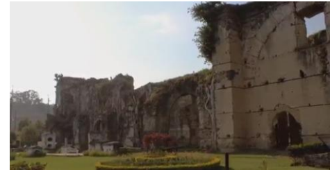
Fuente fotográfica: www.munivillacanales.com/villacanalesenimagenes.html# Pagina oficial Municipalidad de Villa Canales
