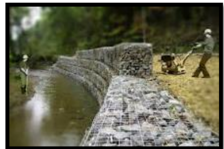
Ilustración 20, representación de la colocación de gaviones en el área.
