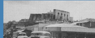
Castillo de San José de Buena Vista, en el Parque Nacional, zona Sur. Autoría: Carlos Luján Aragón Aragón. Fuente: Museo Histórico del Ejército Guatemalteco. Foto: Carlos Luján Aragón Aragón. © 2019. Guatemala, G.atemala, G.
