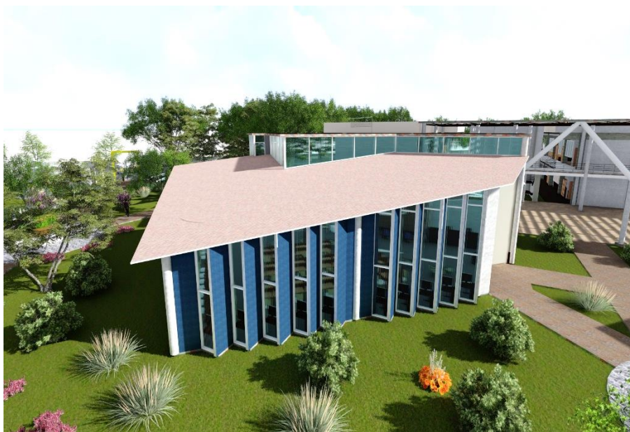
Vista a parte luces de Biblioteca
