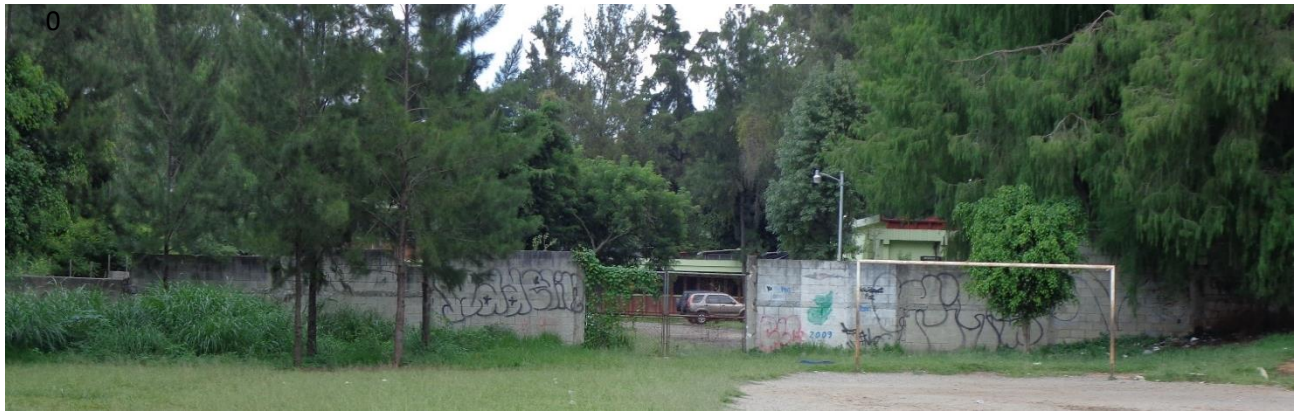
Vista hacia EFPEM colindancia Norte, muro delimitador.
