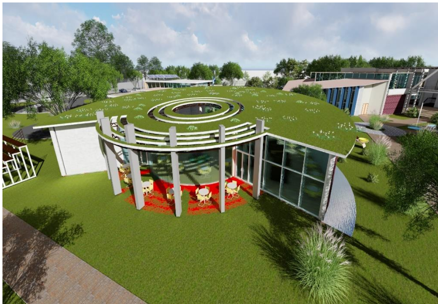
Área Exterior Cafetería
