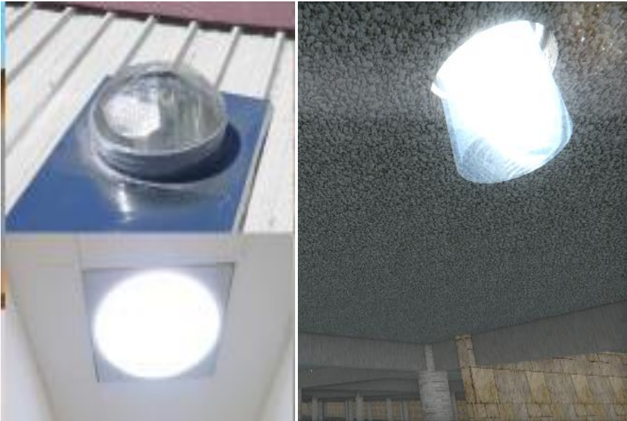
Tubos solares en sótano
