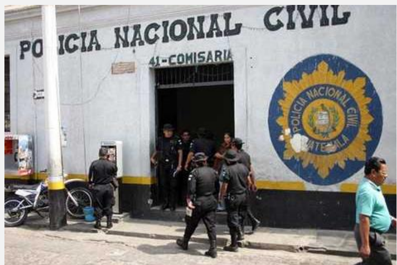
Imagen 27. Subestación de la Policía Nacional Civil. Fuente: Propia.
