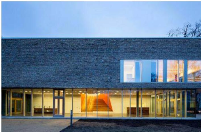
Sobriedad en el aspecto formal exterior del centro deportivo. Se utiliza fachaleta de tipo rústico. La atención visual se logra a través de la transparencia del primer nivel. El manejo de la iluminación cálida interna permite generar el rebote de los colores en muros.
