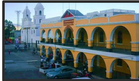
El sistema constructivo del edificio municipal es tradicional (muros de block y estructura de concreto) se intentó integrar a su contexto por medio de los elementos clásicos.
