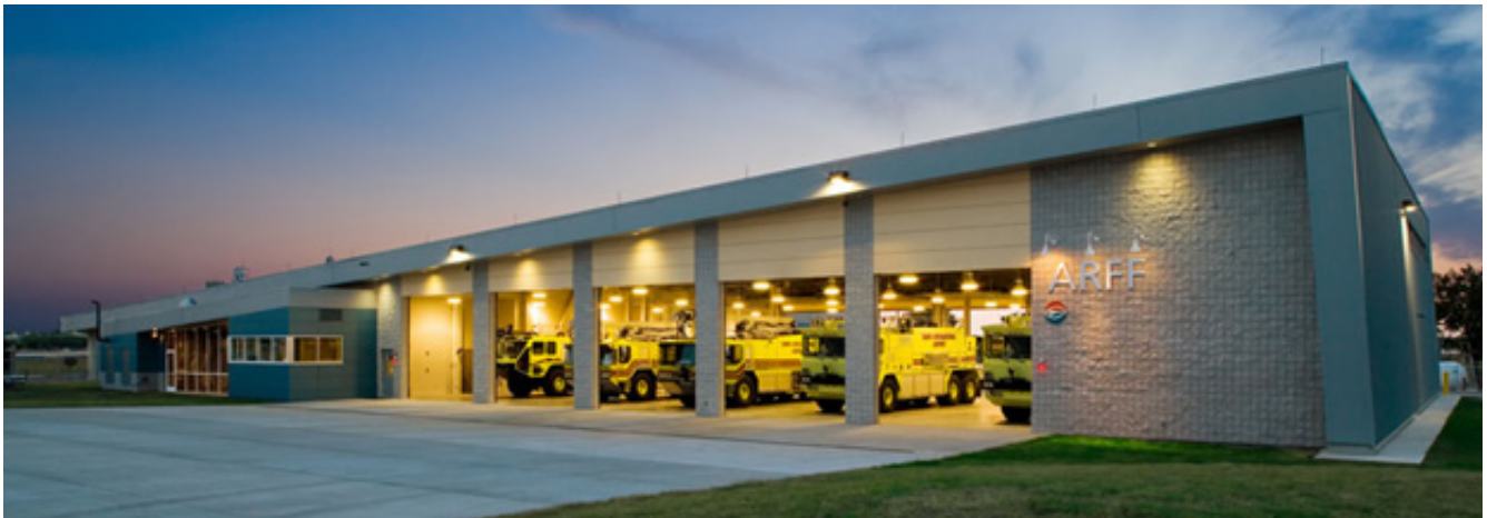
Imagen 24: Fachada principal de la estación de bomberos de Tampa. Fuente: Google Image 2015.
