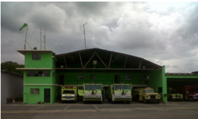
Imagen 1: Estación de Bomberos del Aeropuerto La Aurora vista de frente. Fuente: Julio Monroy.
