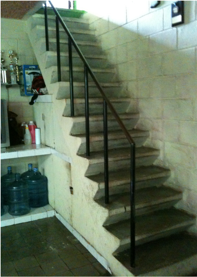
Imagen 21: Escaleras que conducen hacia el segundo nivel de la estación. Fuente: Elaboración propia.
