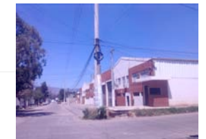
Calle Principal, el uso del suelo es mixto viviendas/industrial.
