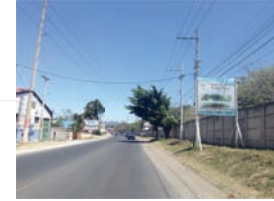
Ruta departamental RD-1, asfaltada de dos carriles
