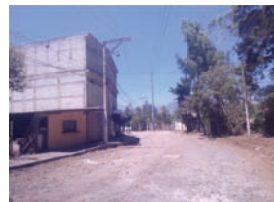
Fin de calle pavimentada e inicio de viviendas rurales
