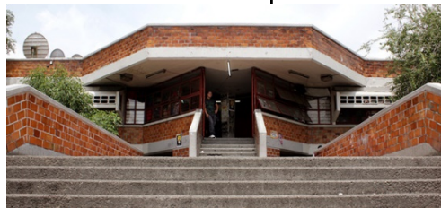
IMAGEN 43 Salida a Parqueo
