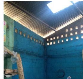
IMAGEN 10 Muros de mampostería del mercado actual
