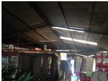
IMAGEN 9 Cubierta de estructura metálica y lámina del mercado actual
