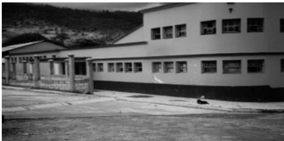
Fachadas de la Escuela tipo Federación No.1 de Palencia, 2008
