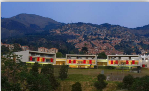
Fotografía No. 73 Integración edificio/entorno Fuente: www.plataformaarquitectura.com.cl , mayo 2016
