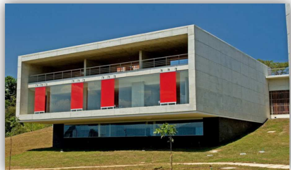
Fotografía No. 74 Uso de celosías en fachadas críticas Fuente: www.plataformaarquitectura.com.cl , mayo 2016
