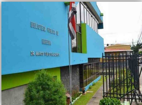
Fotografía No. 61 Ingreso hacia la biblioteca Fuente: www.bibliotecaheredia.com.cr Mayo 2016
