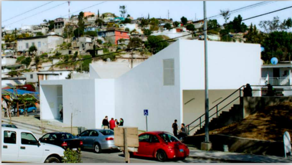
Fotografía No. 69 Integración edificio/entorno Fuente: www.plataformaarquitectura.com.cl , mayo 2016
