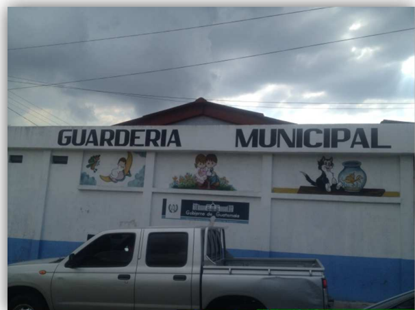
Fotografía No. 38 Guardería municipal (colindancia)
