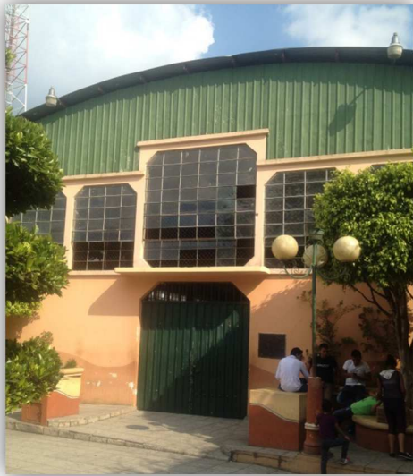
Fotografía no.33 puerta principal del gimnasio
