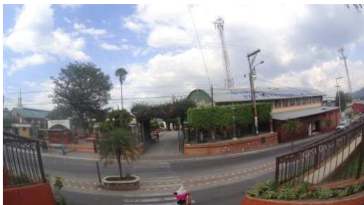
Fotografía No. 1 Vista exterior del parque central y gimnasio.
