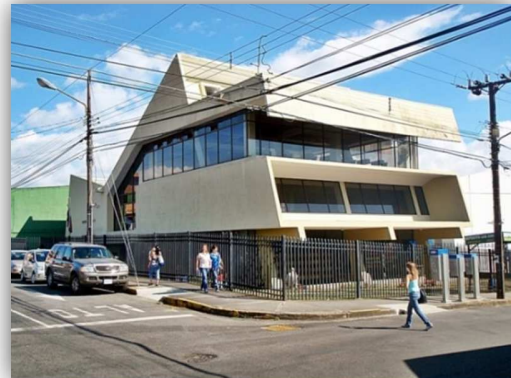
Fotografía No. 62 Perspectiva del edificio desde la calle. Fuente: www.bibliotecaheredia.com.cr Mayo 2016
