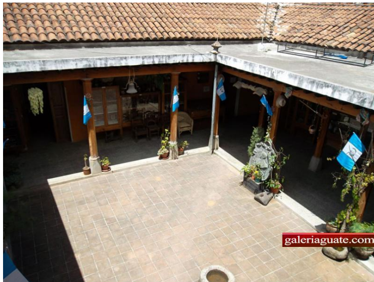
Fotografía 5 Instalaciones de la casa de la cultura
