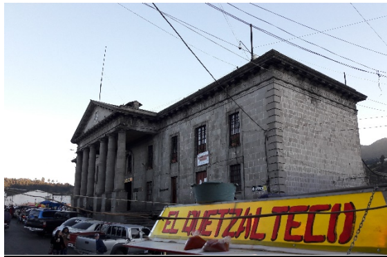
Figura 1 Fachada de la casa de la cultura Quetzaltenango
