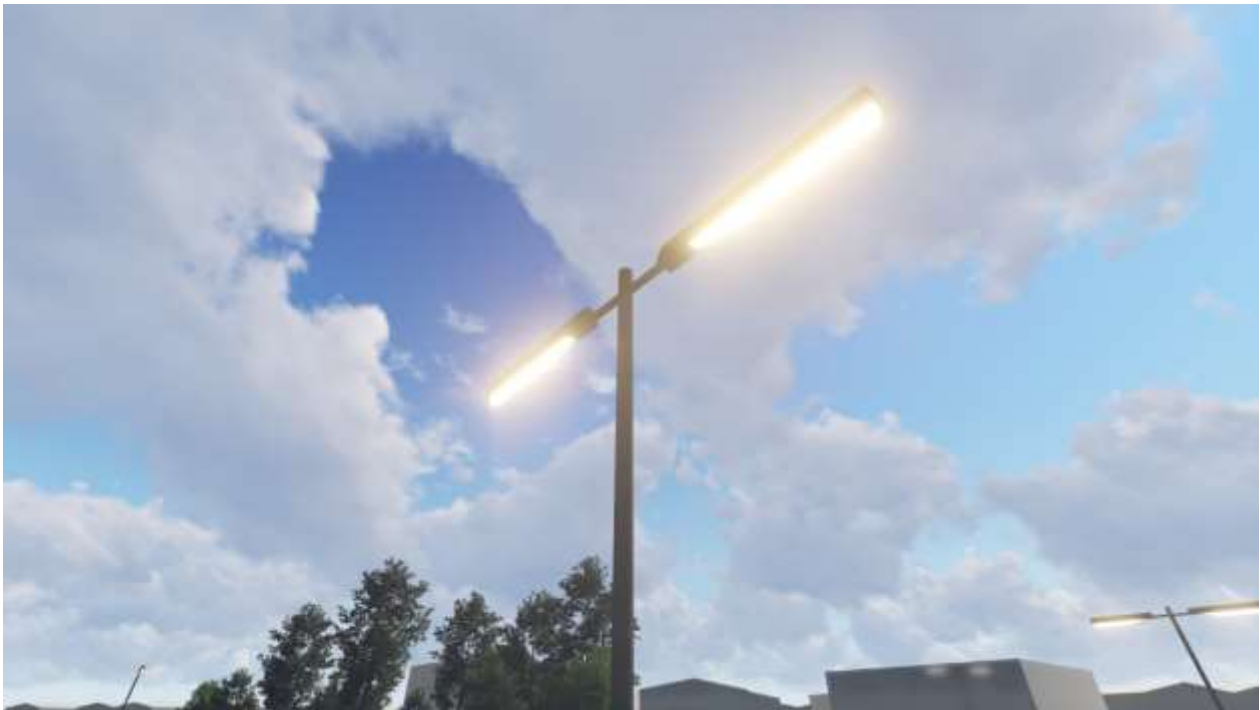
Detalle de iluminación pública tipo led para tener ahorro de energía.
