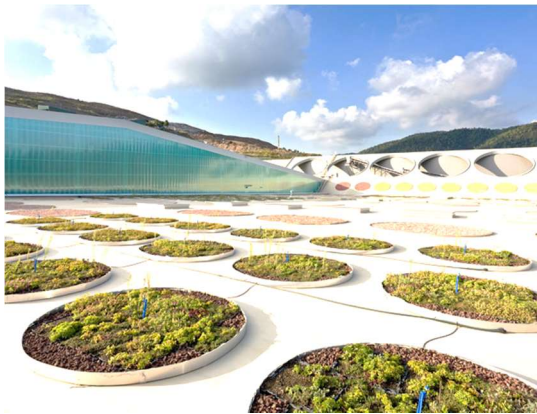
Imagen 19. Cubierta ecológica del Centro de Tratamiento de Residuos Sólidos. Vacarisses. Fuente: www.batlleiroig.com
