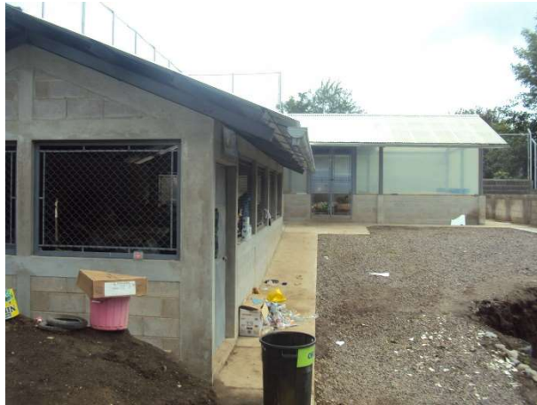
Foto 7. Vista exterior de las áreas de almacenamiento y áreas donde se lleva a cabo la clasificación manual de los residuos. Foto propia tomada en mayo de 2016.
