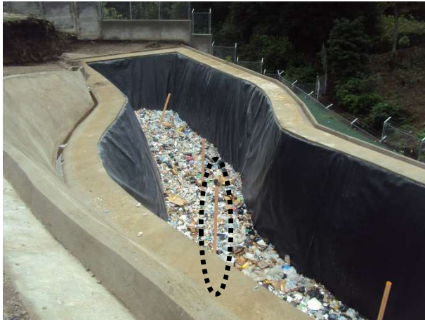
Foto 3. Relleno Sanitario en funcionamiento con la presencia de respiraderos y drenaje para lixiviados. Foto propia tomada en mayo de 2016.
