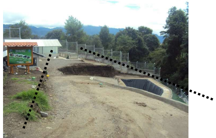
Foto 4. Ingreso de camiones a la planta de tratamiento de residuos sólidos, mediante una rampa de terracería hacia las áreas de descarga. Foto propia tomada en mayo de 2016.
