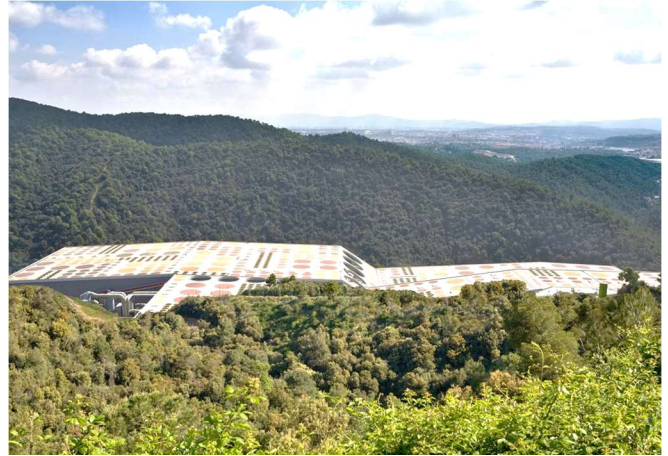
Imagen 18. Integración del proyecto con el entorno natural. Centro de Tratamiento de Residuos Sólidos. Vacarisses. Fuente: www.batlleiroig.com
