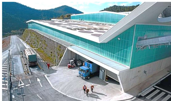
Imagen 23 Utilización de elementos de vidrio y estructura combinada con marcos estructurales de acero y de hormigón armado. Fuente: www.batlleiroig.com
