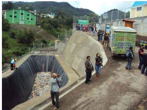
Foto 8. Vista del acceso de los camiones a la planta, a un costado de la rampa de acceso se encuentra el área de relleno sanitario protegido con la presencia de muros de contención. Debido a la topografía del terreno se optó por esta medida. Foto propia tomada en mayo de 2016.
