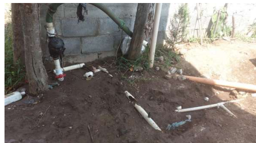
POZO DE AGUA EN CONSTRUCCIÓN, DE 100 MTS DE PROFUNDIDAD
