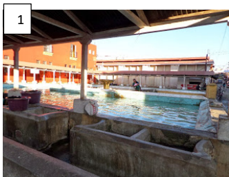
1 Lavadero Municipal ubicado en la plaza central de Sumpango Fuente: Propia
