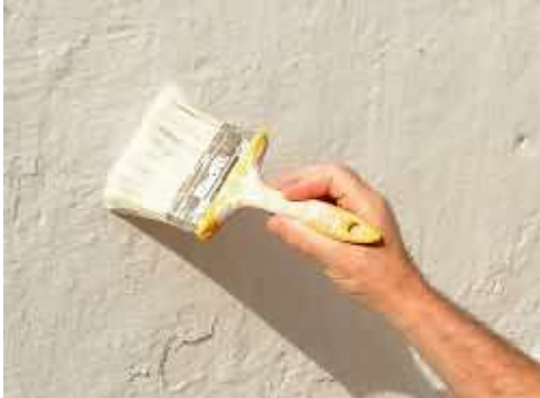
Estuco de cal, acabado rustico
