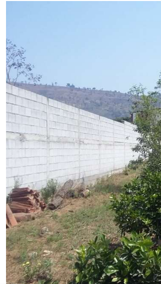
CONTAMINACIÓN VISUAL DE MATERIAL DE CONSTRUCCIÓN ABANDONADO
