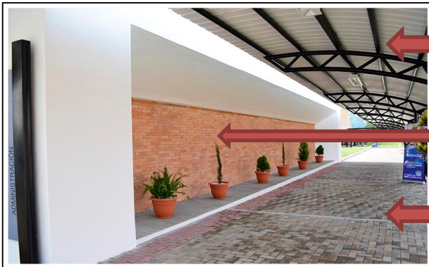
Fotografía 2: Vista exterior, corredor exterior, Intecap Salamá
