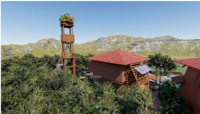
Cisterna elevada que distribuye agua a gravedad, en la parte superior se encuentra el tanque para aguas potable y en la parte baja el tanque de aguas grises tratadas,
