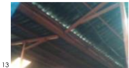
13 La cubierta está conformada por estructuras metálicas y lamina ondulada de zinc.
