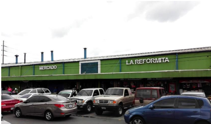
Fotografía 11. Fachada del mercado reformita. Fuente: http://portal.muniguate.com/
