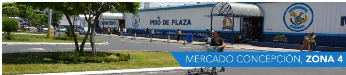
Fotografía 20. Ingreso al área de piso plaza. Fuente: Municipalidad de Villa Nueva (Guatemala 2017).
