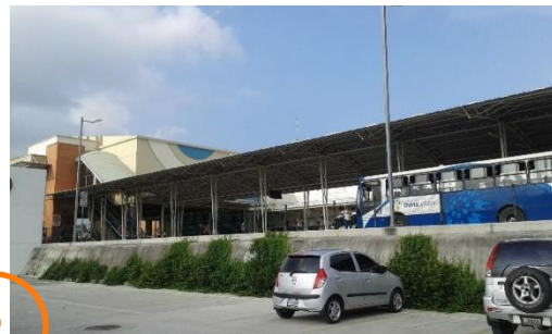
Figura 49 Centra Norte Área de estacionamiento vehicular. Fuente: Elaboración Propia.
