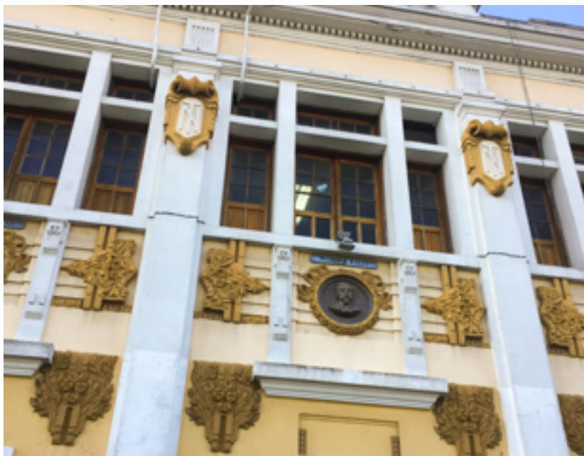
Figura 80 - Columnas del edificio de la Tipografía Nacional.
