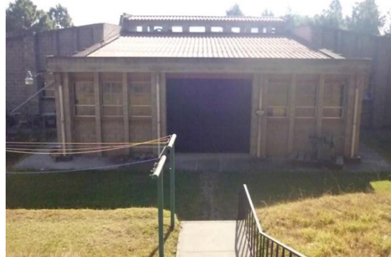
Fotografía 11 Ingreso a la lavandería
