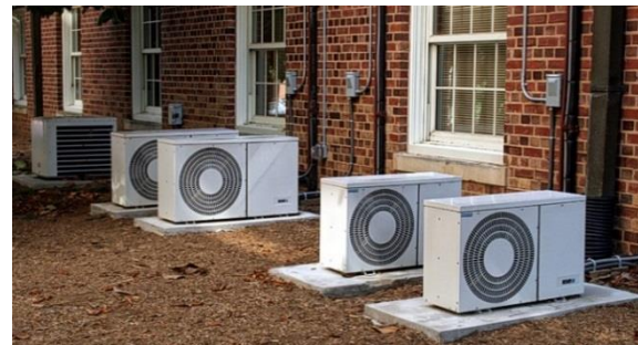
Imagen 63. Aumento del uso de Aire Acondicionado. (www.ecologiaverde.com)
