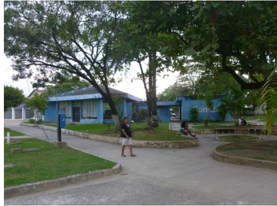
Imagen 30. Entorno jardinizado de la biblioteca existente. Fotografía propia.
