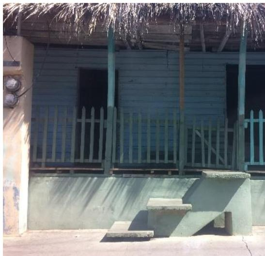
*Figura 9 Materiales utilizados, madera y cubierta vegetal*
