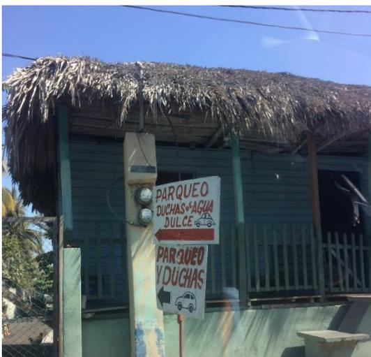
Figura 7 Muros de madera y cubierta vegetal
