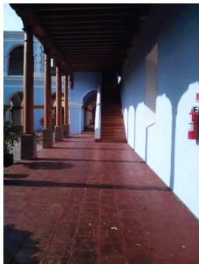
En la fotografía se observan las columnas en madera de ciertos pasillos, con basamentos en piedra tallada
