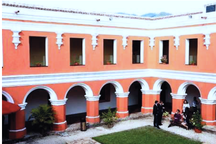
En la imagen superior se observan las columnas a base de ladrillos y los arcos de medio punto estructurales.
