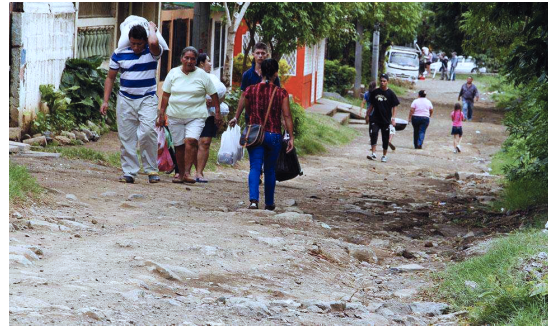
Calle sin pavimentar al sur del terreno Imagen No. 17. Fuente: Visita de campo mayo de 2017.
