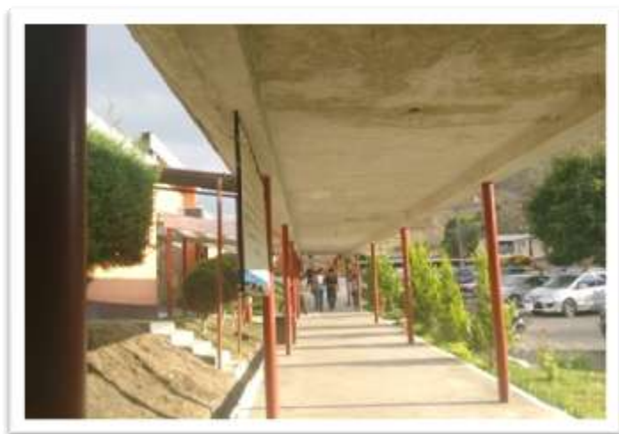
Figura 21 CORREDOR BAJO TECHO. CENTRO UNIVERSITARIO DE NOR OCCIDENTE CUNOROC.
