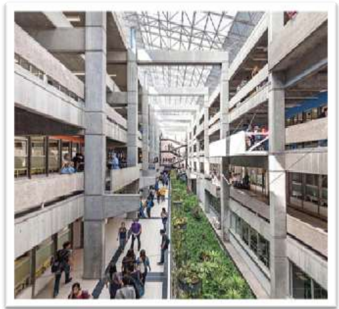
Figura 73 INTERIOR DE EDIFICIO.
