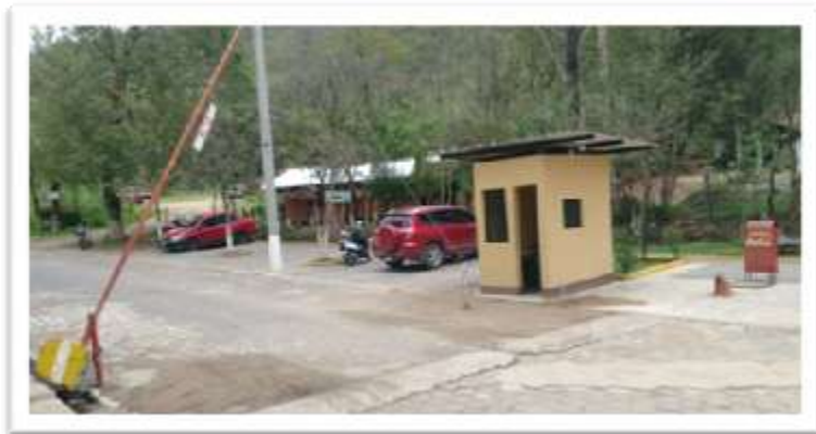
Figura 83 GARITA Y PARQUEO DE CLIENTES.
