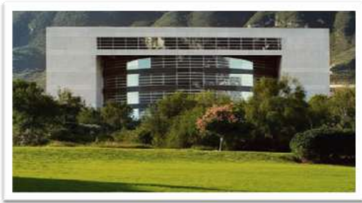
Figura 69 EDIFICIO DE LA RECTORIA UNIVERSIDAD DE MONTERREY
