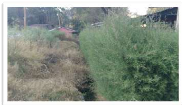
Figura79 ZANJÓN DE ESCORRENTÍA PLUVIAL.
