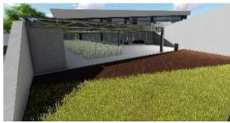
Usar muros bajos en pasillos o balcones los cuales sean un cerramiento parcial de la envolvente con el fin de propiciar corrientes de aire en el edificio.
