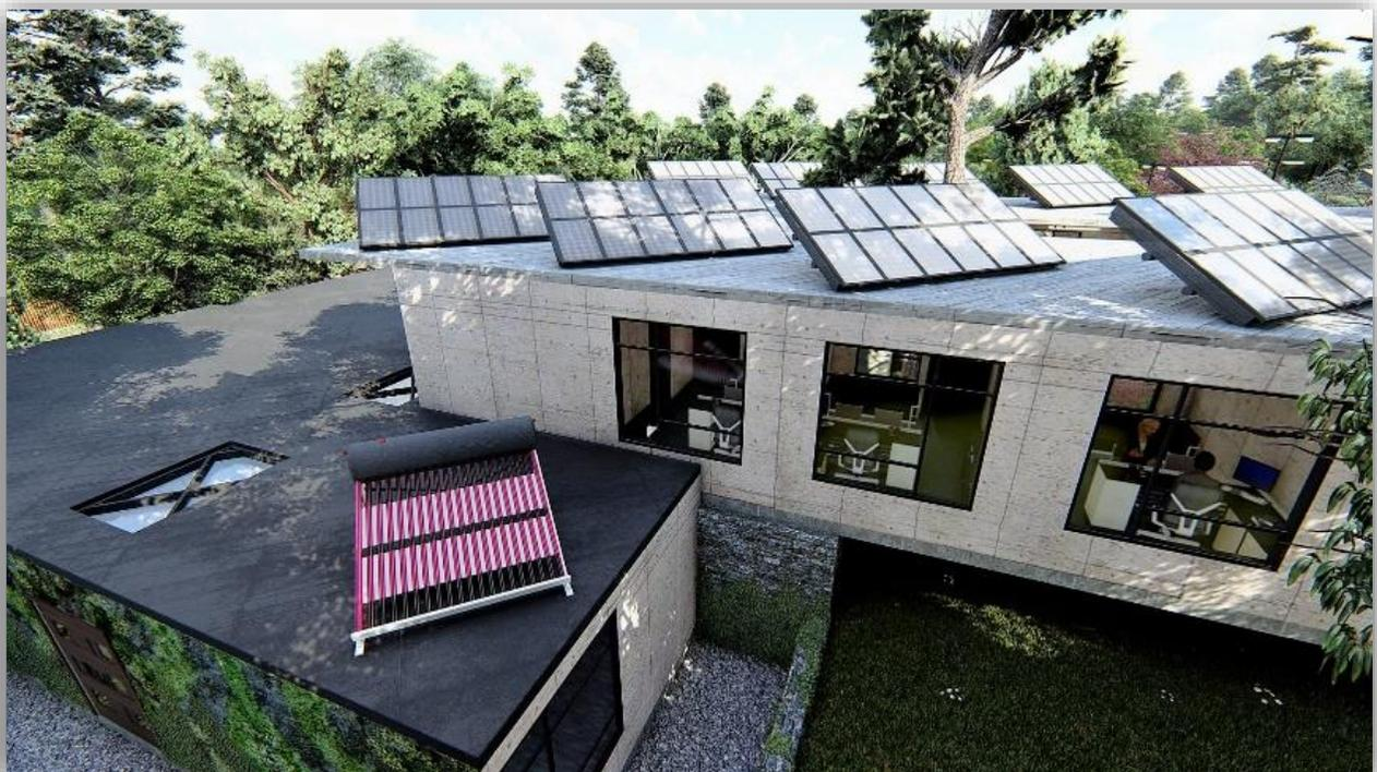
Paneles Fotovoltaicos Y Calentadores De Agua Solares
