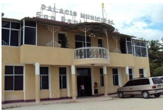
Fotografía 33: Fachada Lateral Izquierda Municipalidad, fotografía en geoview, http://gt.geoview.info/palacio_municipal_san_benito_peten,4309099p
