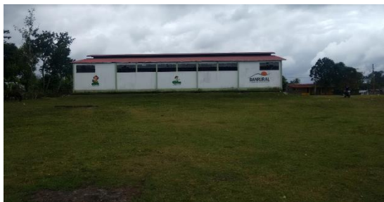
Figura 28: Salón de Usos Múltiples, fotografía propia, El Chal, Petén, Guatemala, 2015
