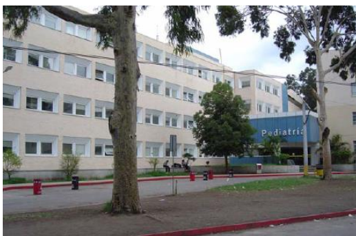
Figura 16: Edificio de Pediatría
