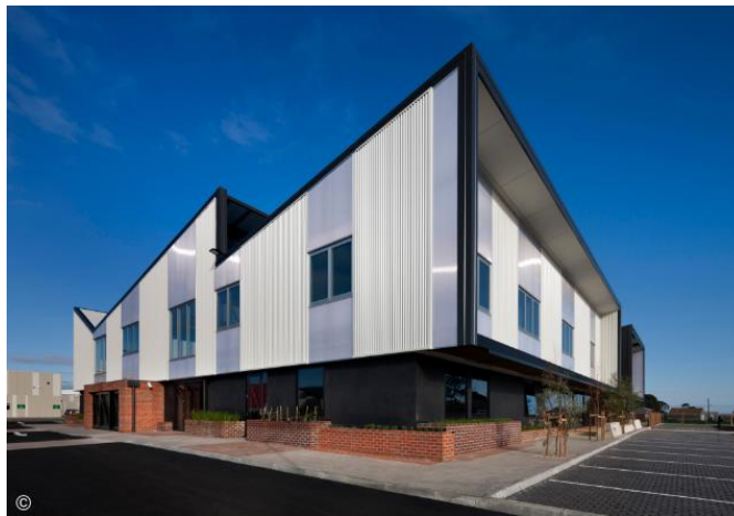
Figura 40: Elevación Este del Centro de Salud Ballarat Fuente: www.archdaily.com
