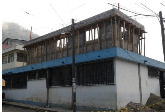
Figura 33: Ampliación en 2do nivel.
