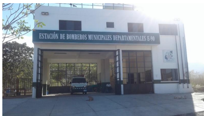
Figura 50: Estación de Bomberos Municipales Fuente: Fotografía propia
