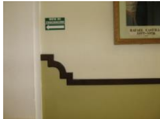
Detalle de zócalo en ingreso norte
