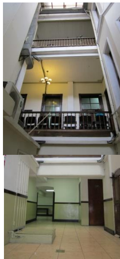
Vista de N a S. obsérvese la integración espacial y la triple altura
