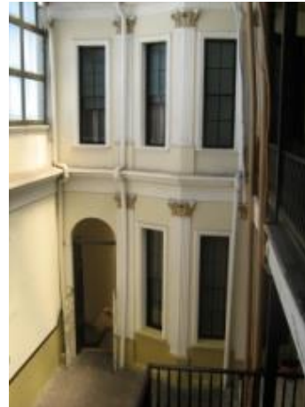
2) Arco No. 2 que conduce al sótano, vista de P. a O
