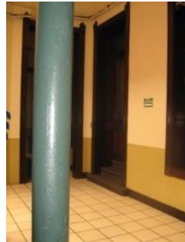
Pisos y zócalo en corredor
