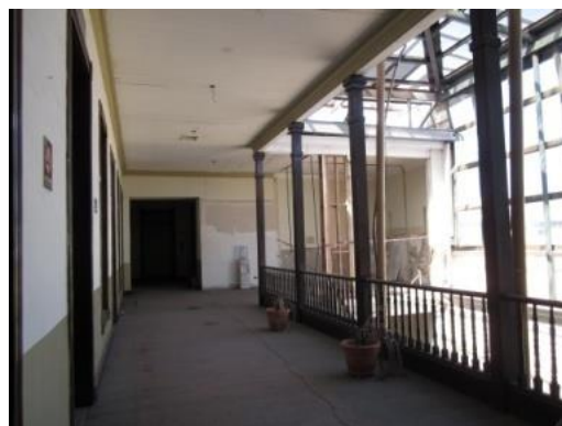
Vista general de muros de E. a O.
