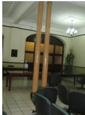
Vista de muros que rodean el salón Larrazábal, y columnas de metal
