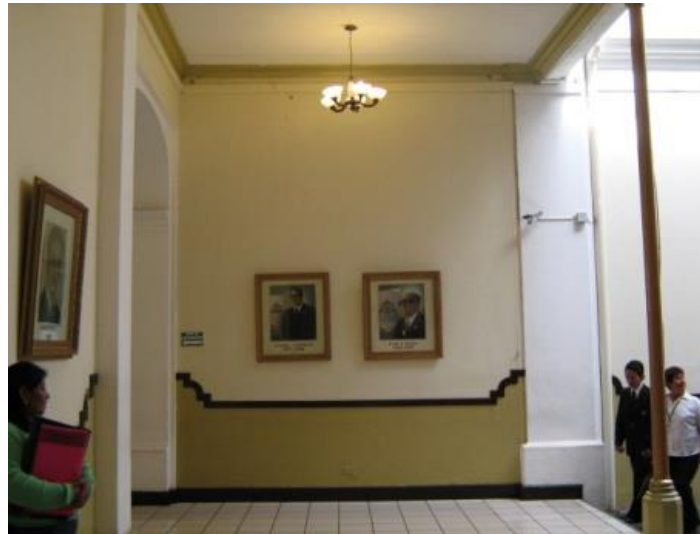
Vista parcial de muro norte en ingreso principal
