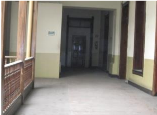
Vista de E. a O. , ala sur, se observa parte del piso y zócalo
