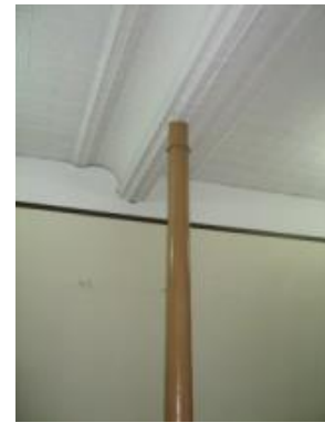
Integración de muro, viga y columna de metal
