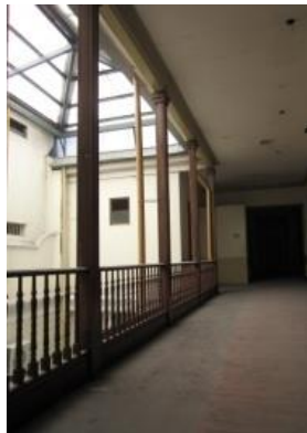
1) Baranda, vista de E. a O.
