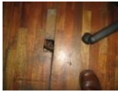
2) Piso en interiores
