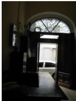
Arco en puerta principal de ingreso norte, vista de O. a P.
