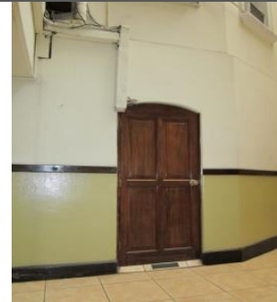
Puerta No. 2, en octógono, vista de E. a O.
