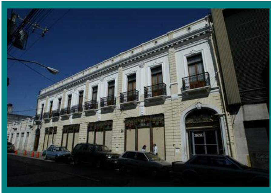
FACHADA CASA LARRAZÁBAL
