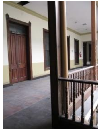
Piso y zócalo, vista de SO. a NE
