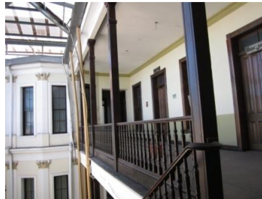
Vista general de P. a O. de ventanas y puertas, ala norte
