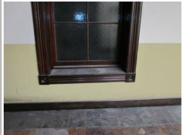
Zócalo y piso en 2do. Nivel}
