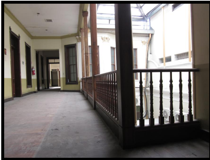
Ilustración No. 60 Vista general ala sur de P. a
