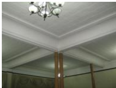
Cielo falso en salón "Larrazábal"
