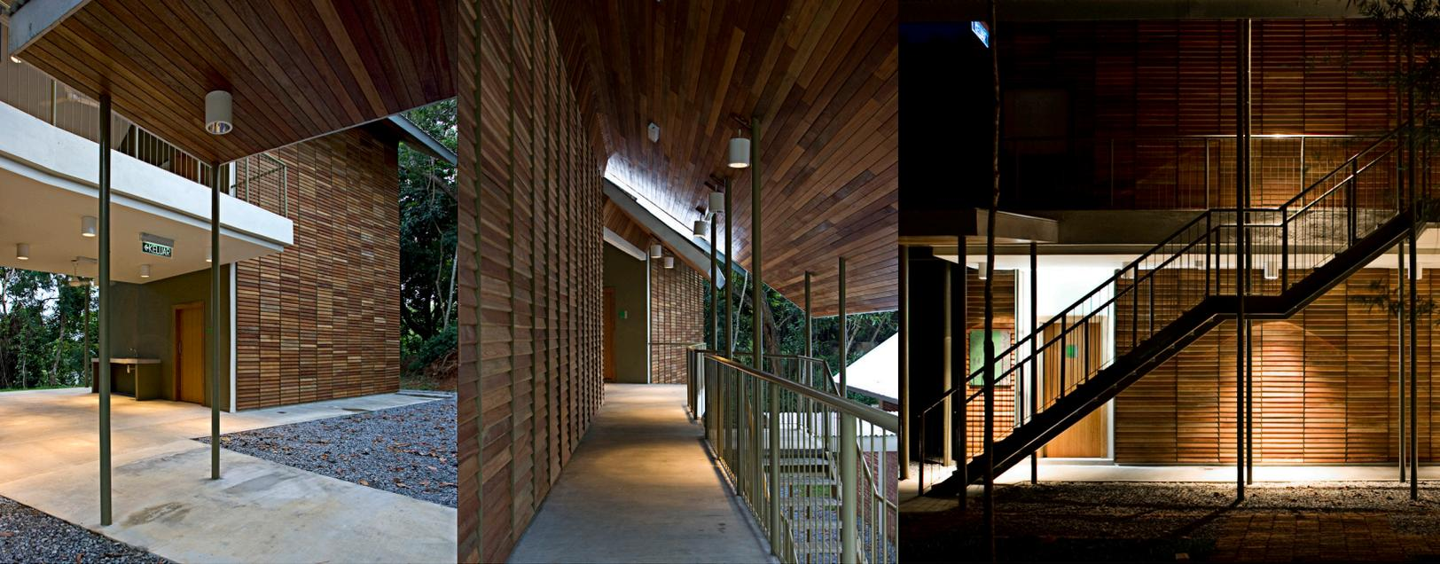
Este complejo costó aproximadamente R\$ 800,000.00 y fue diseñado y construido en un período de seis meses. La superestructura del edificio es de marcos de acero y la piel es una combinación de bloques de peso ligero y revestimiento de madera.
