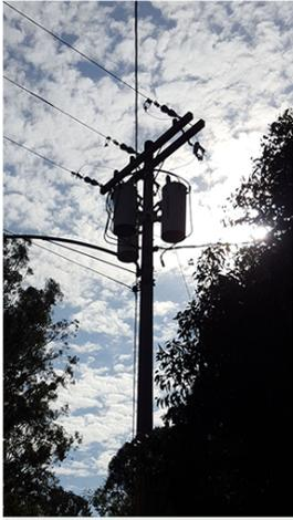
Fig. 74 a la **acometida** ingresan los conductores que provienen de un poste con transformador el cual se encuentra en la acera frente al terreno.
