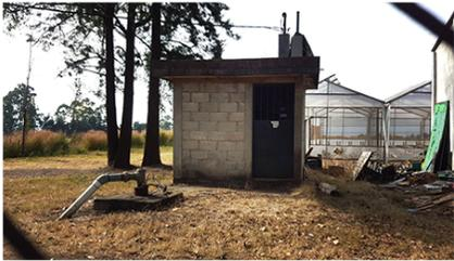
Fig. 73 La **toma de agua** se realiza por medio de un pozo y un sistema hidroneumático para el cual se cuenta con otra acometida.
