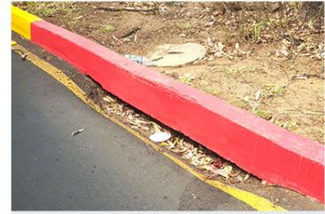
Fig. 76 El **drenaje de las aguas pluviales** en la circulación se da hacia el camellón central del boulevard universitario, estos se tapan con hojas y/o basura.
