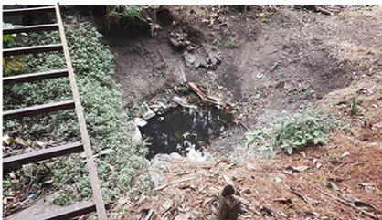
Fig. 71 El **drenaje** se realiza hacia un pozo ciego de parte de las instalaciones del CEDA, así mismo, el drenaje de agua pluvial se manda a la quebrada, donde se ha empozado el agua.
