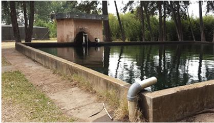
Fig. 72 Del pozo el agua se coloca en un **tanque de captación** para mantener una reserva así como captar agua de lluvia para el constante riego de las
