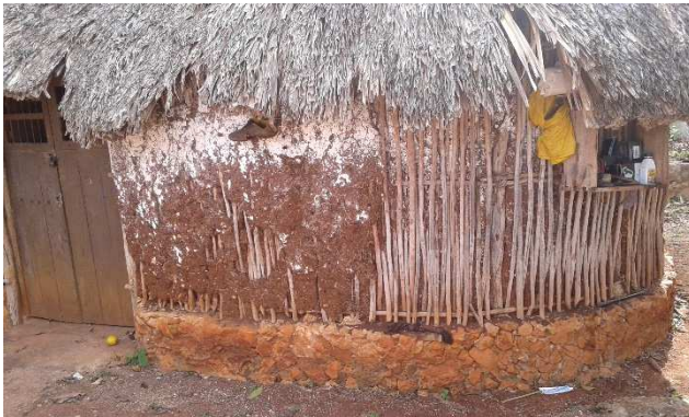
Figura 42: Casa de bajareque. Fotografía propia. (Yucatán, México, 2016)
