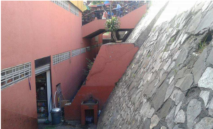
Figura 9: Muros de contención. Fotografía propia. (Mercado Central, Ciudad de Guatemala, 2017)
