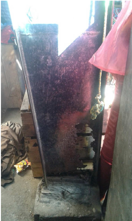
Figura 59: Estructura metálica de cubierta de mercado municipal, Cubulco, Baja Verapaz. Fotografía propia (2017)
