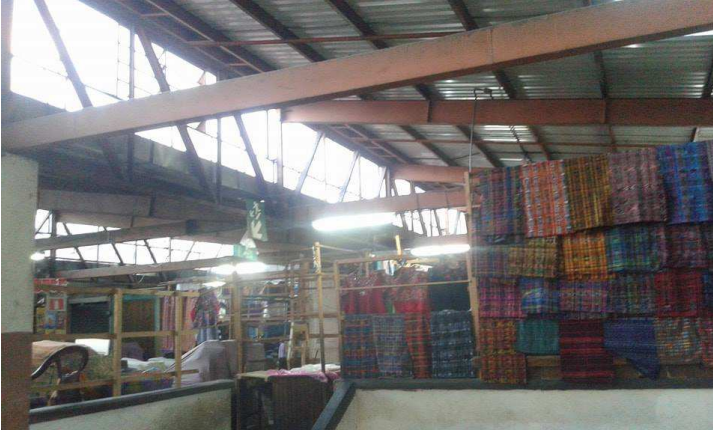
Figura 22: Techo, segundo nivel. Fotografía propia. (Mercado Municipal, San Pedro Sacatepéquez, San Marcos, Guatemala 2017)
