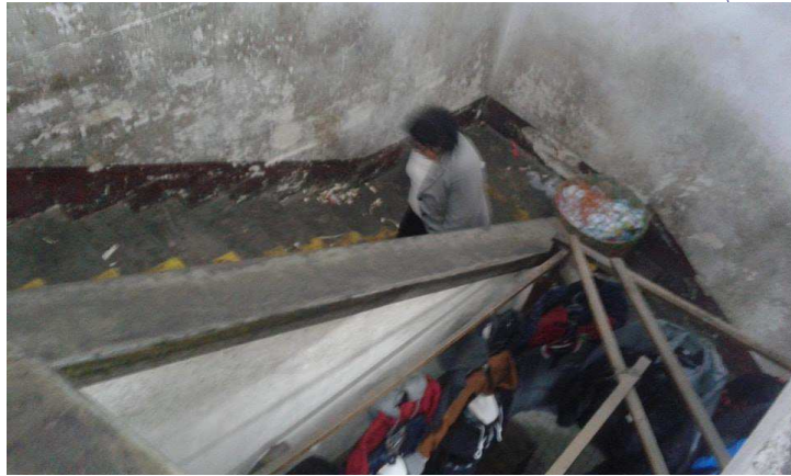
Figura 13: Módulo de gradas. Fotografía propia. (Mercado Municipal, San Pedro Sacatepéquez, San Marcos, Guatemala 2017)
