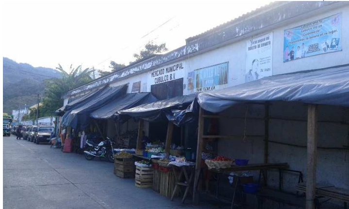
Figura 56: Mercado Municipal de Cubulco, Baja Verapaz. Fotografía propia (2017)
