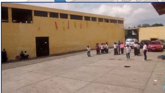
Edificio parroquial de dos niveles y otros servicios, Se encuentra mal distribuido internamente y no aporta ningún estilo arquitectónico.
