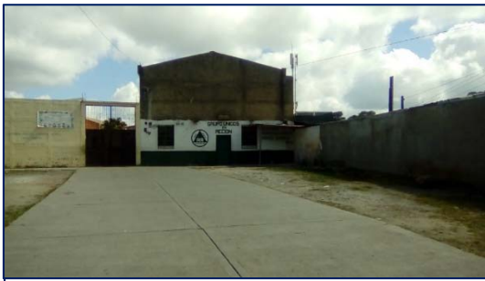
Área destinada para deporte y recreación ya que no cuentan con más espacio dentro del establecimiento existente.
