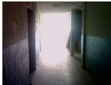
Pasillo de ingreso
