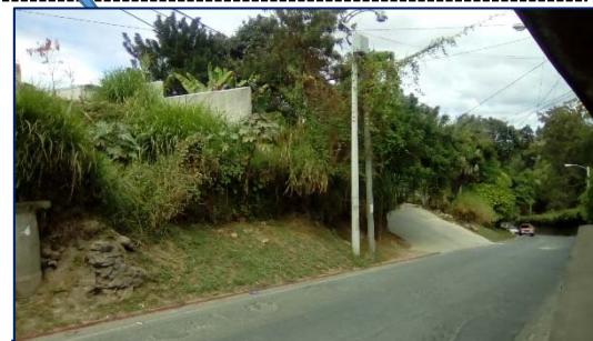
Calle Real Las Tapias, pavimentada para al acceso al terreno anexo. Esta calle tiene todos los servicios de infraestructura, agua potable, drenajes e iluminación.
