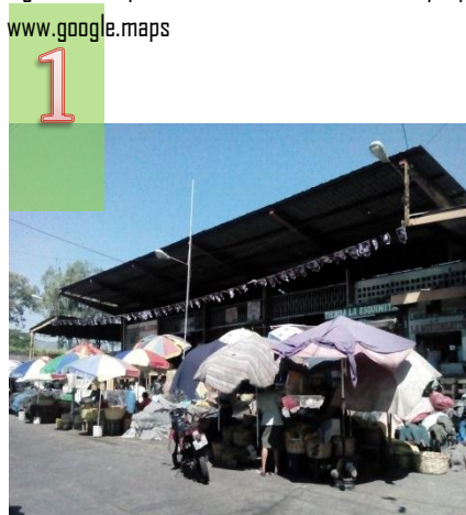
Figura 58: Entrada principal a la bodega utilizada como mercado, fotografía propia, marzo 2015
