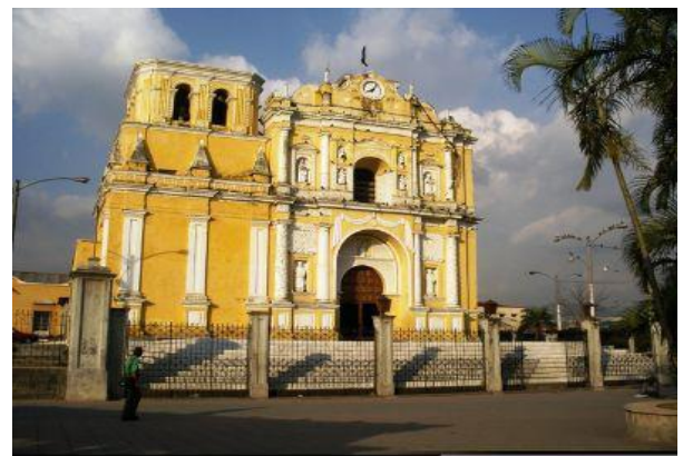
Figura 47: Catedral de Escuintla, fotografía propia, noviembre 2014
