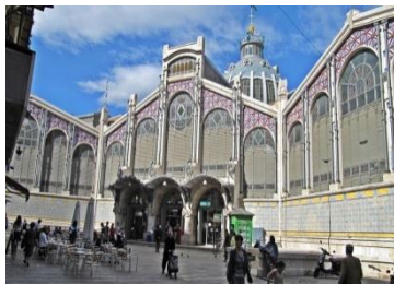
Figura 104: Acceso principal, Mercado Central de Valencia, fotografía de www.mercadocentralvalencia.es/
