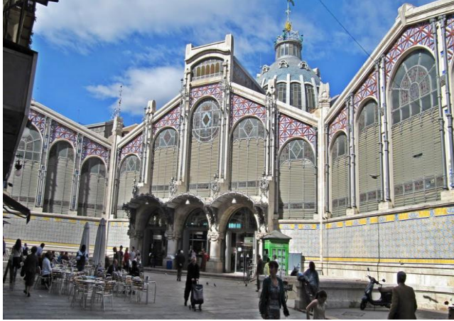
Figura II: Acceso principal, Mercado Central de Valencia, fotografía de www.mercadocentralvalencia.es/
