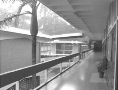
Ilustración 12: Liceo Guatemala, estructura
