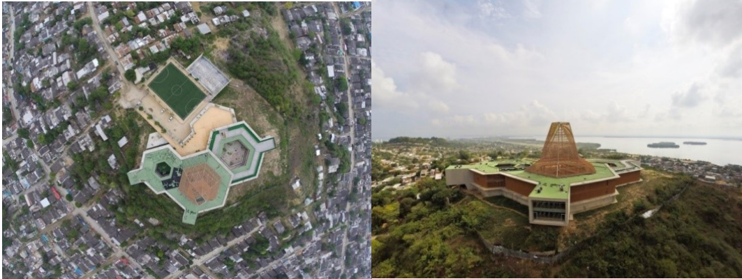
Ilustración 26; Colegio Pies Descalzos, vistas.
