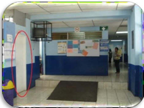
Fotografía #29, elaboración propia
