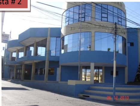
Imagen # 13 elaboración propia, Municipalidad del progreso, Jutiapa
