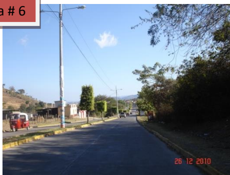
Imagen # 17 elaboración propia, Avenida principal de ingreso al pueblo llamado la calzada.
