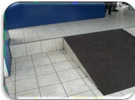
Fotografía #30, elaboración propia
