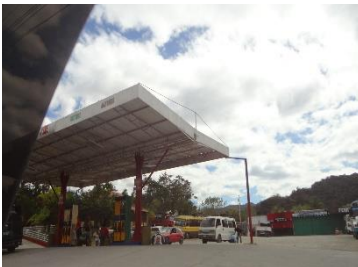
Imagen 27 7- Gasolinera de San José del Golfo; Fuente propia.
