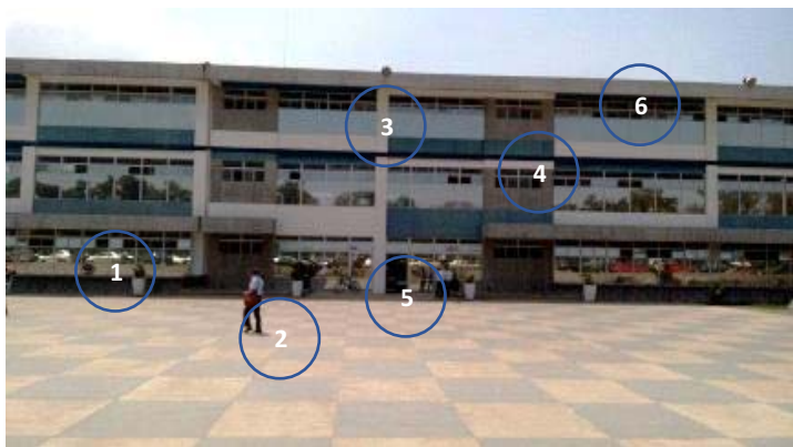
Imagen 33 DIGA. Fuente: Propia
