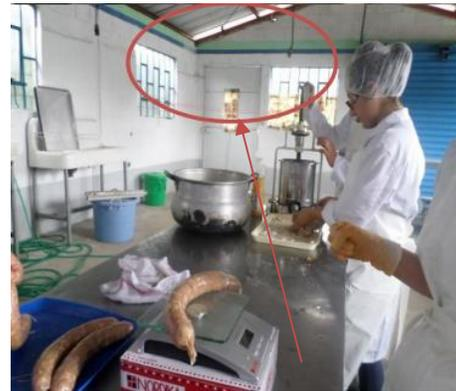
**Fotografía No.25** Techo Es de lámina y se encuentra con boquetes que permiten con más facilidad que ingrese la contaminación o bacterias del exterior
