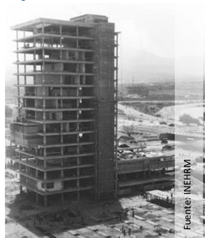
Ilustración 72: Proceso constructivo, Registro Histórico
