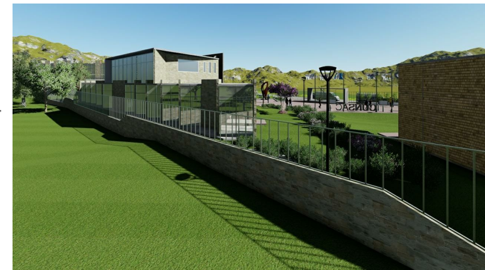
VISTA NORTE DEL EDIFICIO ADMINISTRATIVO
