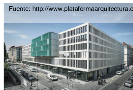
Ilustración 48: Exterior Des Quais
