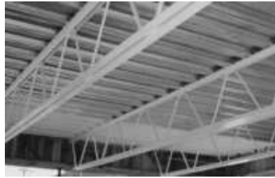
Vigas Joist cargando lámina galvanizada.
