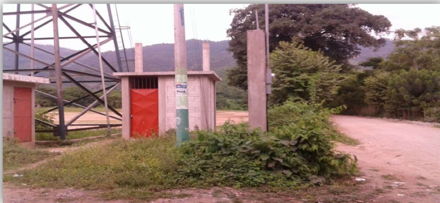
Foto 18. Instalaciones de postes de luz (Elaboración Propia)
